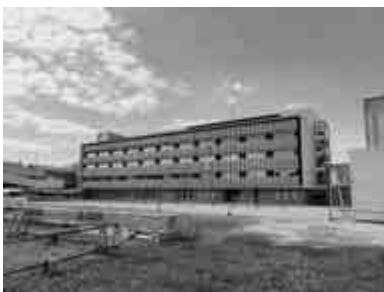
【外構工事が進む市庁舎】
